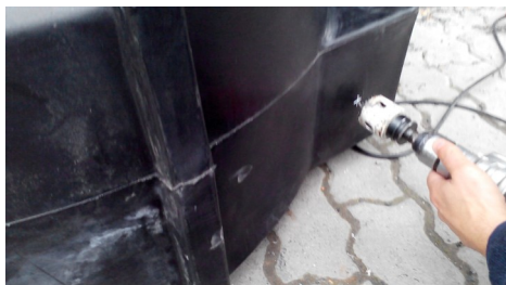
2. bemenetek kifűrése
